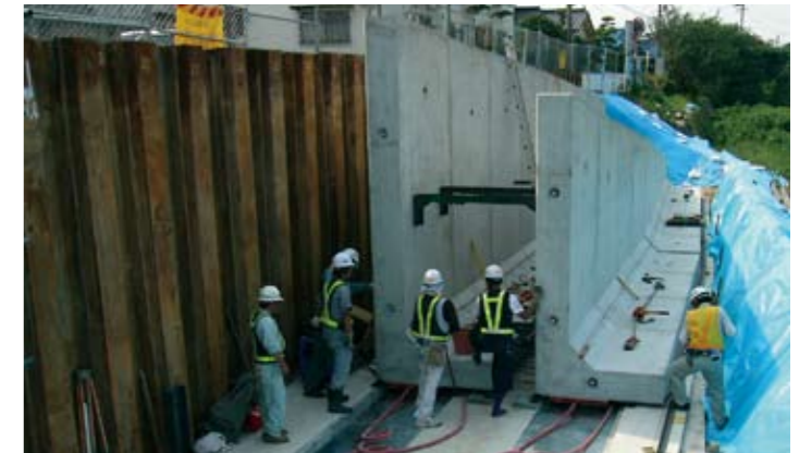
L型部材の連結施工例 [w=11.6t]
