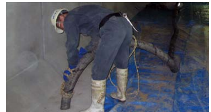
底版モルタル充填工例
