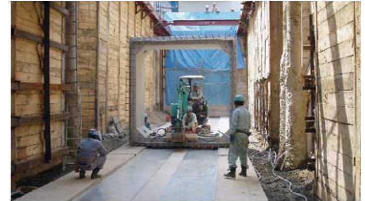
V字勾配区間の施工例 (縦断折れ角 1°06' 05") [w=12.2t]
