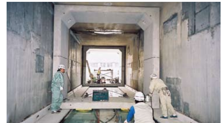
狭隘部分の施工例 [w=15.8t]
