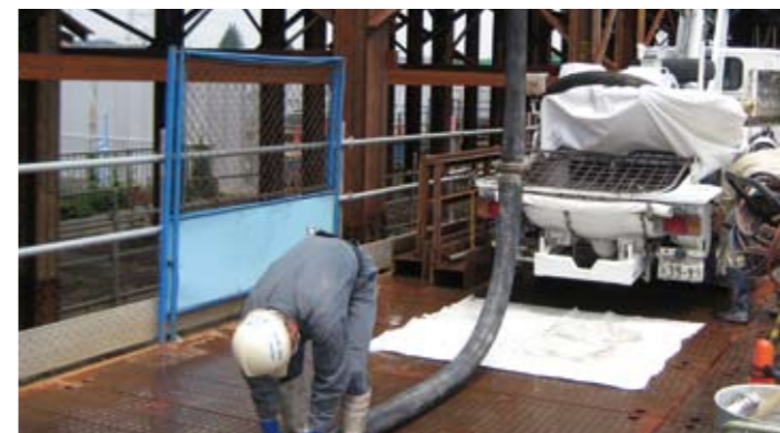
コンクリートポンプ車配管状況例
