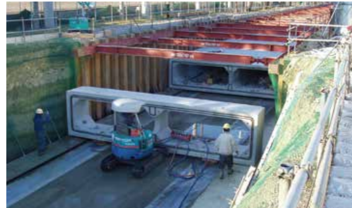
長距離施工例 (移動距離 206m) [w=12.3t]
