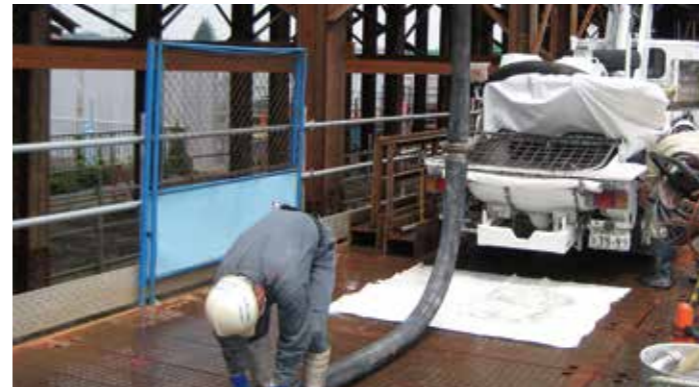
コンクリートポンプ車配管状況例
