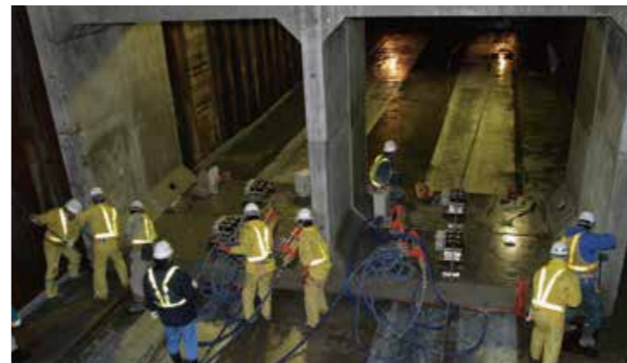
連結施工例 (2 函体連結) [w=67.4t]
