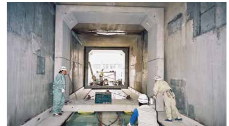
狭隘部分の施工例 [w=15.8t]
