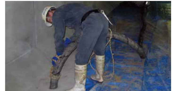
底版モルタル充填工例
