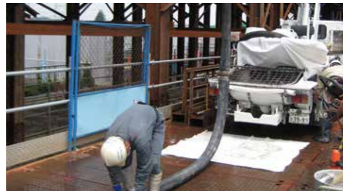
コンクリートポンプ車配管状況例
